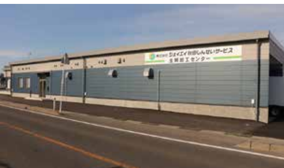
▲3月から稼働している生鮮加工センター
