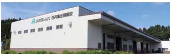
▲平成28年に竣工した花卉集出荷施設
